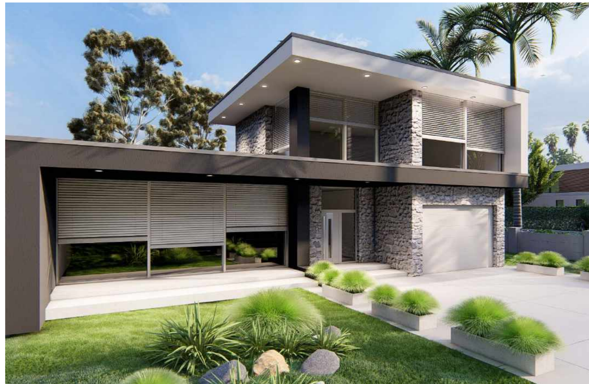
Fassade mit Raffstoren, Tür MB-86 SI mit Seitenteil und Oberlicht, Modell Texas INOX, Farbe, hell Grau.
