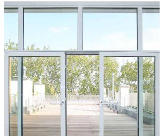
Schiebeelemente bringen ein deutliches Plus an Wohnraum. Bei ihnen entfällt der Schwenkbereich von Fenster- und Türflügeln. So kann der Wohnraum auch direkt vor dem Fenster genutzt werden.
